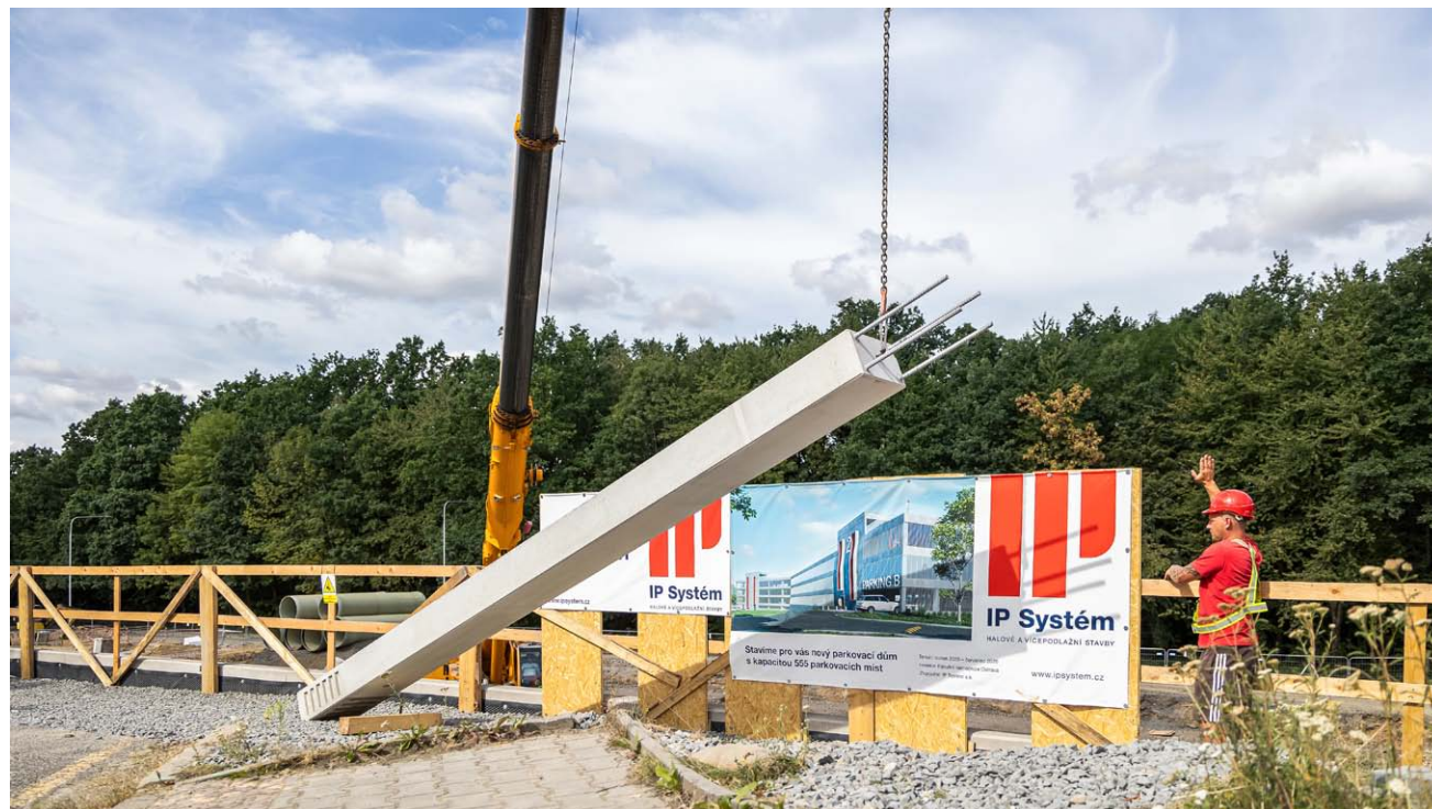
Každý sloup nového parkovacího domu ve FN Ostrava je umístěn do pilotů hlubokých zhruba 20 metrů.
