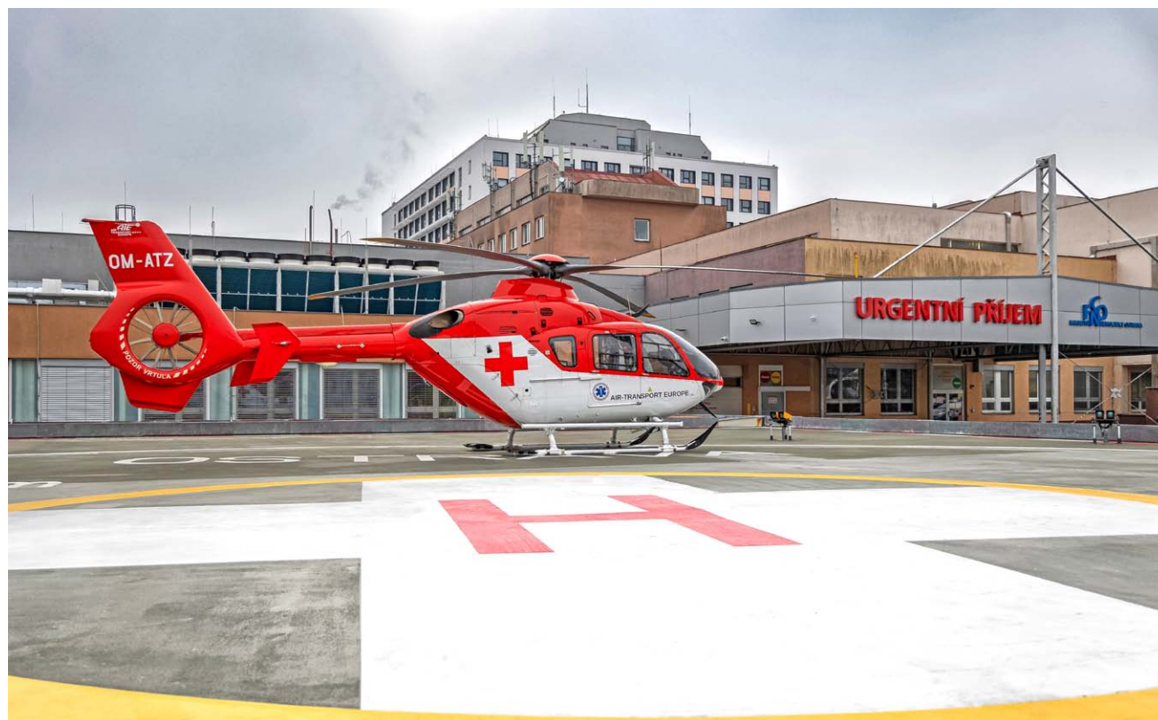
Heliport byl doplněn technologií pro noční provoz a může fungovat plně v souladu s evropskými předpisy v režimu 24/7.
